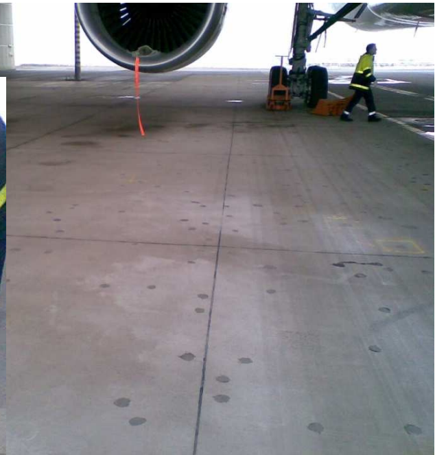
ausgebesserte Betonfläche innerhalb der LSH
