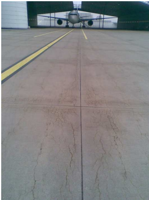
Betonfläche vor der LSH
