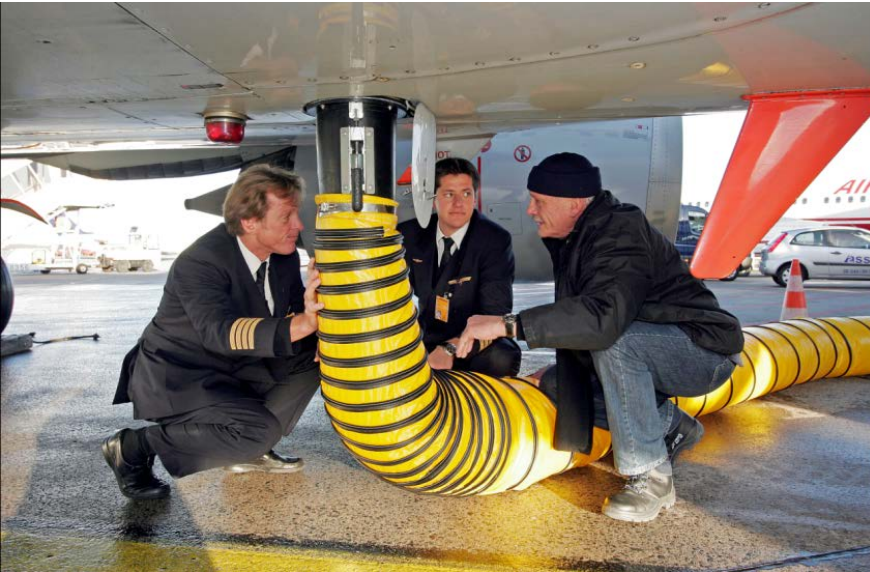
Versorgung über das BHKW an 17 Pier-Positionen
